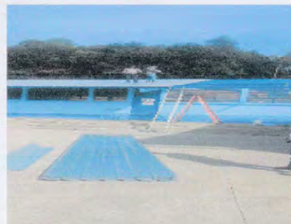
Foto 2: Sustitucion de Lamina
