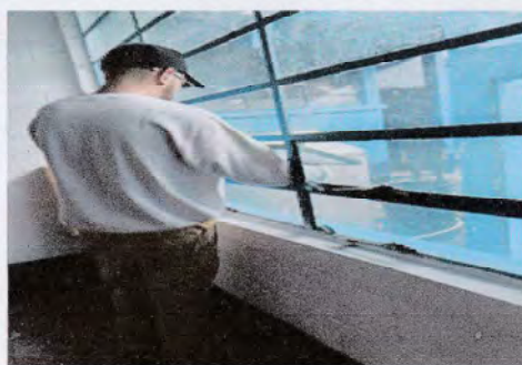
Foto 3: Sustitucion de Vidrios
