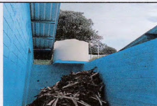
Foto 4: Sustitucion de deposito de agua
