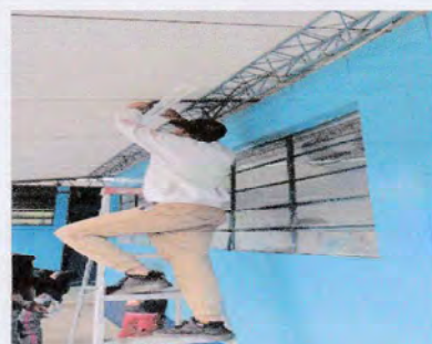
Foto 6: Sustitucion de focos ahorradores
