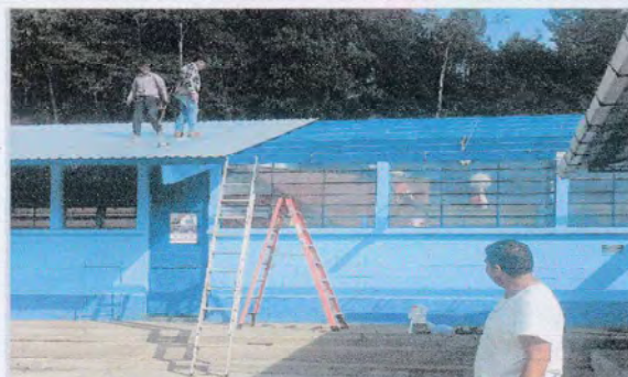
Foto1: Sustitucion de lamina
